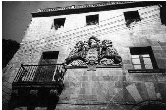
Vista de la Calle Mayor. ▲
